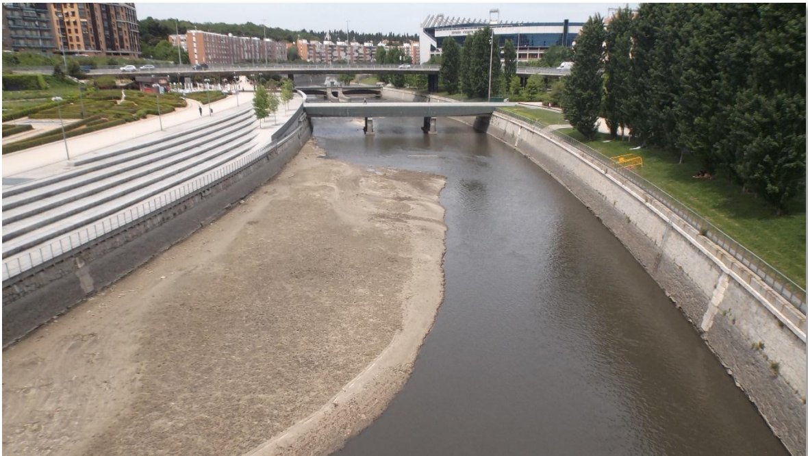
Recuperación del régimen hidrológico y procesos de sedimentación tras la apertura de compuertas, tramo 2 (mayo 2016)
