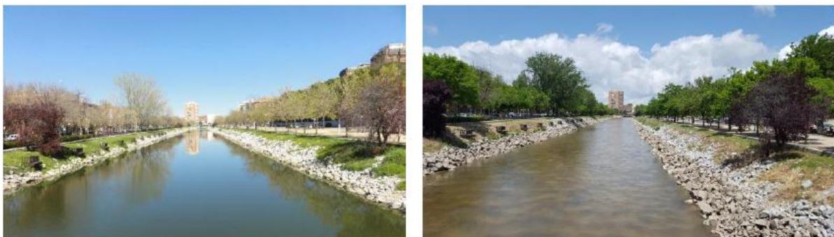
Vista tramo 1 aguas arriba de la pasarela de Almuñécar (izquierda: abril 2016; derecha: mayo 2016)
